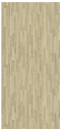
Pogled celotne plošče
