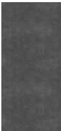
Pogled celotne plošče
